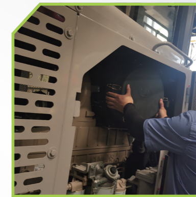
Air cleaner maintenance 空滤清理
